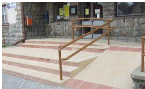
Renovácia schodov pred kultúrnym domom v hodnote 236 tis. Sk. Realizácia: Cestné stavby
