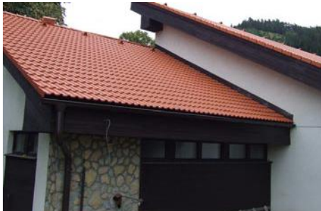
Dom smútku. Výmena strešnej krytiny v hodnote 436 tis. Sk. a inštalovanie informačnej tabule v hodnote 25 tis. Sk. Realizácia: Dollis
