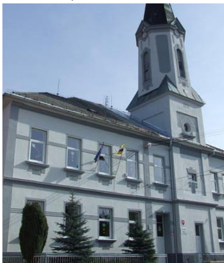
Oprava fasády základnej školy a zvonice, výmena okien, dverí, oprava strechy a zvodov, výmena radiátorov, výmena bleskozvodov v hodnote 2,3 mil. Sk. Realizácia: Stavindustria. Spoluinvestícia Ministerstva školstva SR a Obce Záv. Poruby
