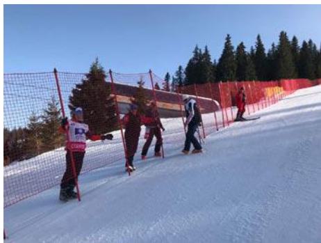
• Stavba bezpečnostných sietí
