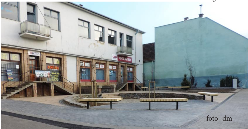
• Revitalizované námestie obce pred COOP Jednota, november 2022
